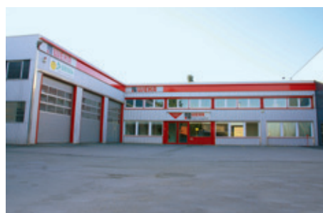
Verwaltung und Reparatur-Durchfahrtboxen
