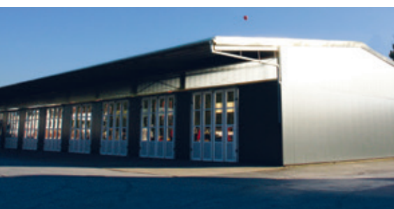
Stahlbau- und Reparatur-Halle
